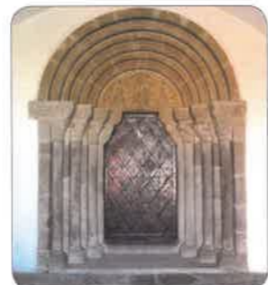
gotický vchod (portál)
